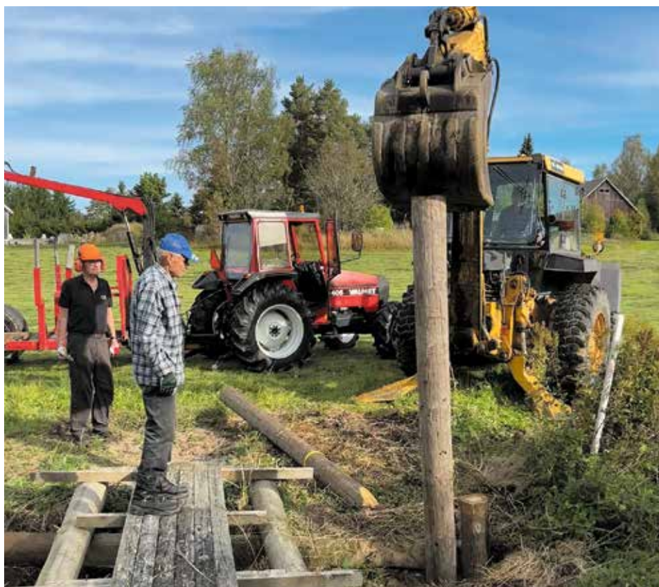
Sillan runkorakennelmissa on hyvä, kun on pelit ja vehkeet. Vasemmalta Markku Laaksonen, Timo Kiri ja kaivinkoneen puikoissa Risto Kemppe. Kuva: Juha Kytömäki.
